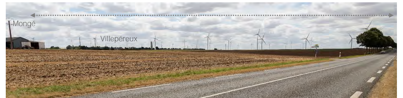
Photographie 35. Vue sur les fermes de Mongé et Villepéroux
