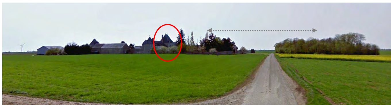
Photographie 71. Le château de Goury depuis la RD109 en entrée est du hameau et le parc en arrière-plan
